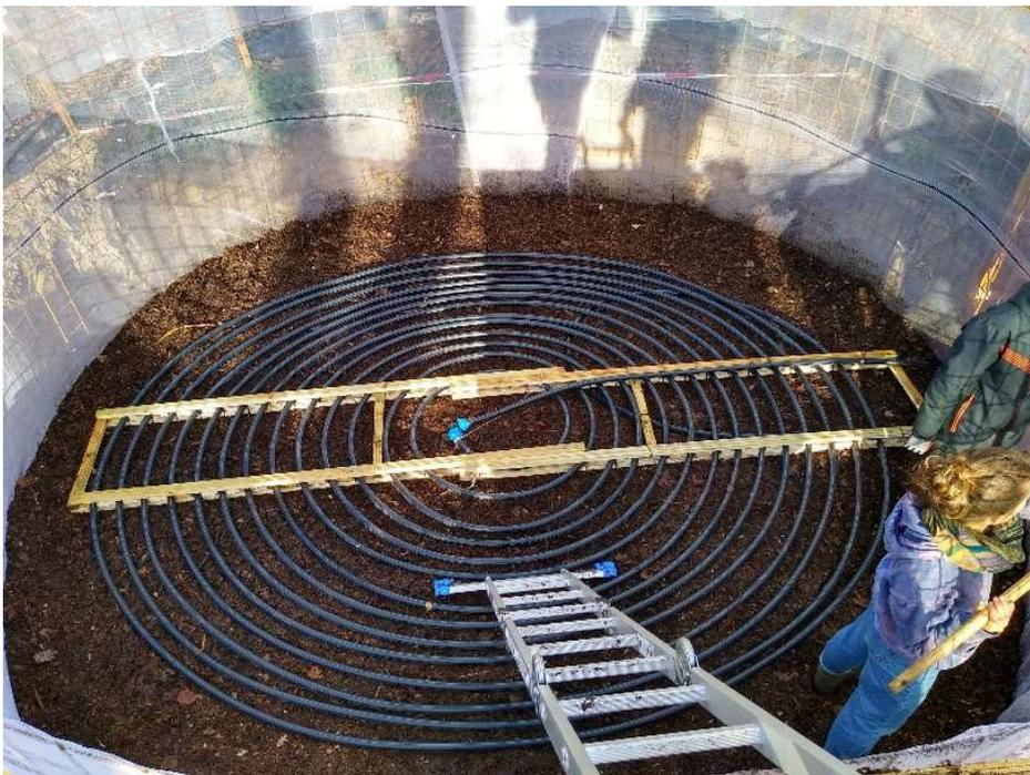
*Der erste Wärmetauscher mit 100 Meter Rohr wird eingelegt. Die Enden führen in einen Schacht am Rande des Biomeilers, in dem sie miteinander verbunden und über eine mit Schafwolle isolierte Röhre zum Haus geführt werden.*
